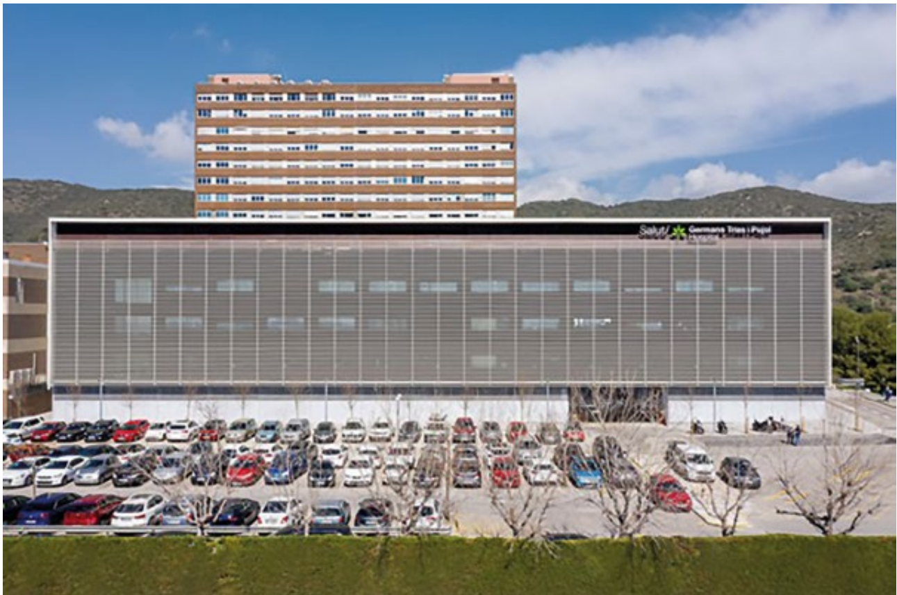
Hospital Germans Trias i Pujol (Barcelona). Instalación de más de 800 unidades CLAGE modelos CEX y MBH.
