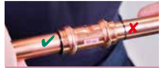
8. Inserte el tubo. Asegúrese de que el tubo está completamente insertado
