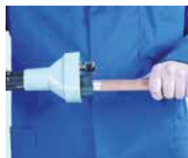
Limpieza exterior del tubo
