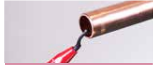
3. Utilice un desbarbador tipo lápiz para los bordes internos
