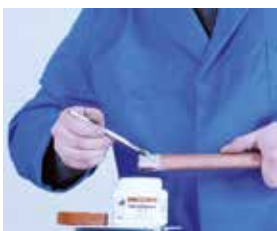
Aplicación del decapante
