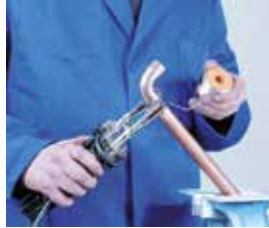
Aplicación de la soldadura fuerte
