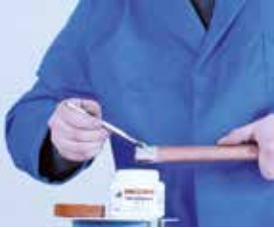
Aplicación del decapante
