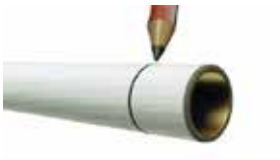
Marcar profundidad de inserción
