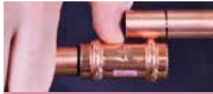
7B. Compruebe la marca de profundidad.
