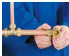
Inserción del tubo en el accesorio
