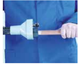
Limpieza exterior del tubo
