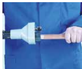
Limpieza exterior del tubo
