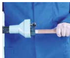
Limpieza exterior del tubo
