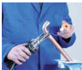
Aplicación de la soldadura fuerte
