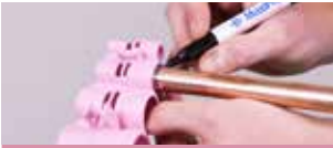
7A. Marque la profundidad de inserción usando el medidor de profundidad
