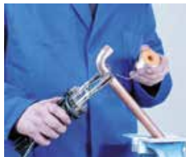
Aplicación de la soldadura fuerte
